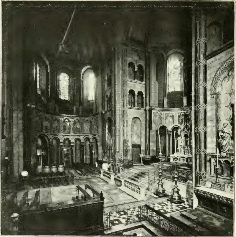
Intérieur du chœur de Saint-Martin-le-Grand.
